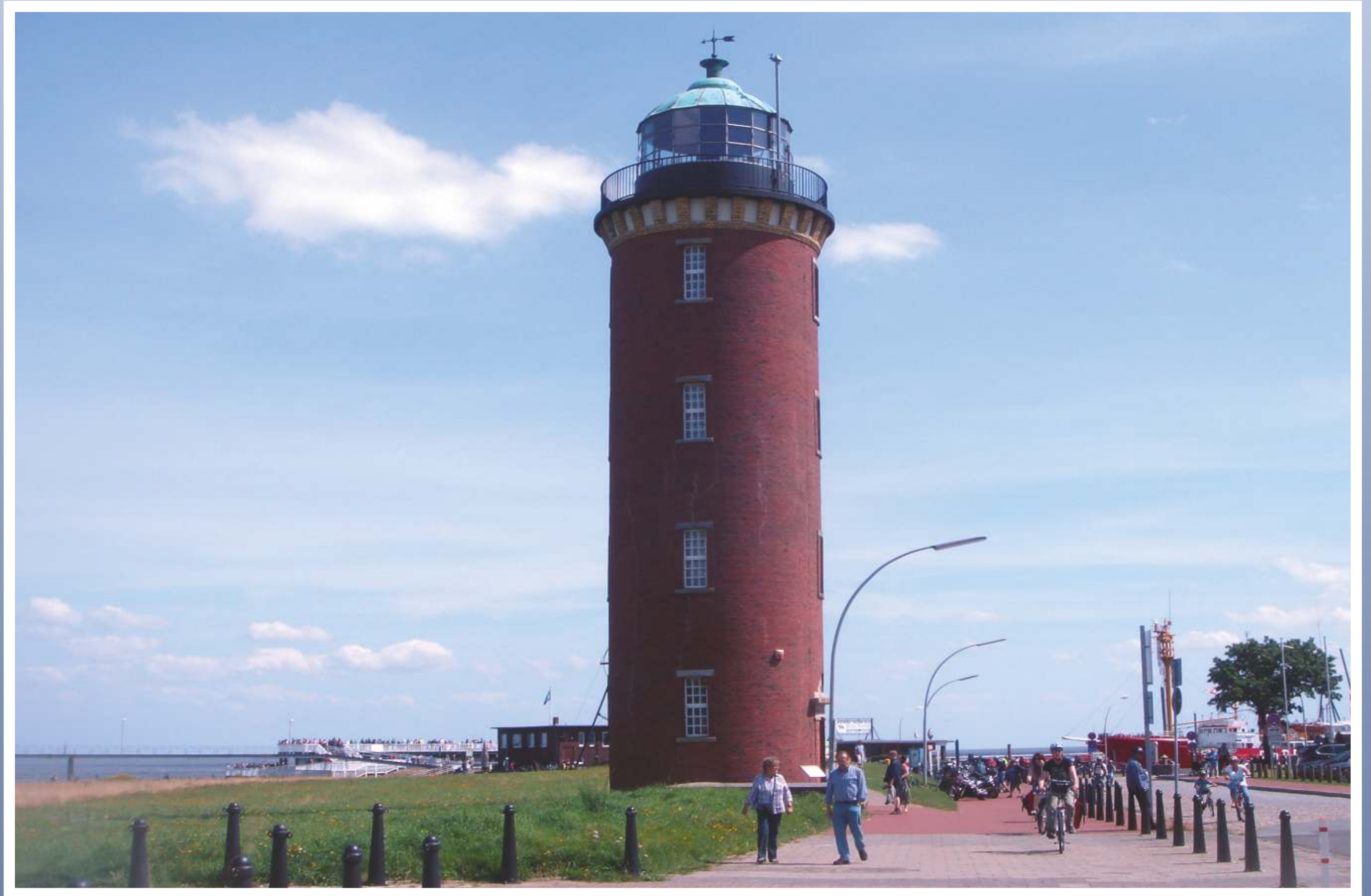
53 Grad 52 Minuten 22 Sekunden nördlicher Breite und 8 Grad 42 Minuten 34 Sekunden östlicher Länge - der ‚Hamburger Leuchtturm‘ in Cuxhaven. Er wurde in den Jahren 1802 bis 1804 bei der ‚Alten Liebe‘ erbaut und war bis anno 2001 in Betrieb.
